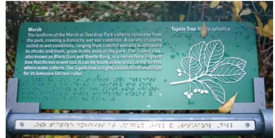
Teardrop Park, Battery Park City, NY, Designer: Coco Raynes, Kate Blehar. Das Raynes-Geländer schließt eine taktilen Zeichnung mit ein, die Charakteristika der Pflanzen erläutert / The Raynes Rail segment incorporates a tactile drawing, which presents the characteristics of the plants
