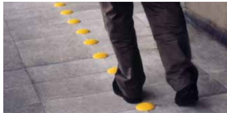
»Tactdots«. Leicht erhöhte Punkte zeigen den Weg, der in der taktilen Karte (oben) verzeichnet ist. Die Punkte geben ein Geräusch von sich, wenn sie mit einem Stock berührt werden. Slightly raised dots delineate the path indicated on the tactile map (above). The dots make a sound when tapped with a cane
